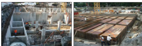
Example of underground storage tank under construction. Once construction is complete, the open space over the storage tank can return to its original function. Note control building in the background (at right in bottom photo). Exemple d'un réservoir souterrain en construction. Une fois la construction terminée, l'espace au dessus du réservoir peut retourner à son utilisation d'origine. Notez l'édifice de contrôle (dans le coin droit de la photo du bas).
