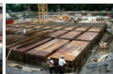
Example of underground storage tank under construction. Once construction is complete, the open space over the storage tank can return to its original function. Note control building in the background (at right in bottom photo). Exemple d'un réservoir souterrain en construction. Une fois la construction terminée, l'espace au dessus du réservoir peut retourner à son utilisation d'origine. Notez l'édifice de contrôle (dans le coin droit de la photo du bas).
