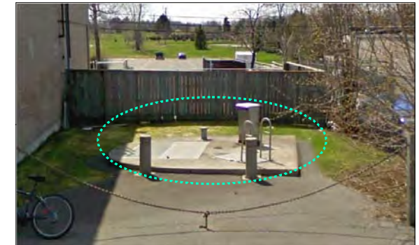
Visible portion of tunnel maintenance access shaft Portion visible d'un puits servant de point d'accès pour l'entretien du tunnel.
