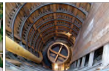
Example of an access shaft used for tunnel construction. Once construction is complete, the shaft allows maintenance access to the tunnel. Exemple d'un puits servant à la construction d'un tunnel. Une fois la construction terminée, le puits sert de point d'accès pour l'entretien.
