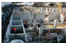
Example of underground storage tank under construction. Once construction is complete, the open space over the storage tank can return to its original function. Note control building in the background (at right in bottom photo). Exemple d'un réservoir souterrain en construction. Une fois la construction terminée, l'espace au dessus du réservoir peut retourner à son utilisation d'origine. Notez l'édifice de contrôle (dans le coin droit de la photo du bas).
